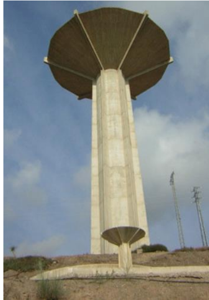
Figura 11 – Depósito de agua en Lorca
