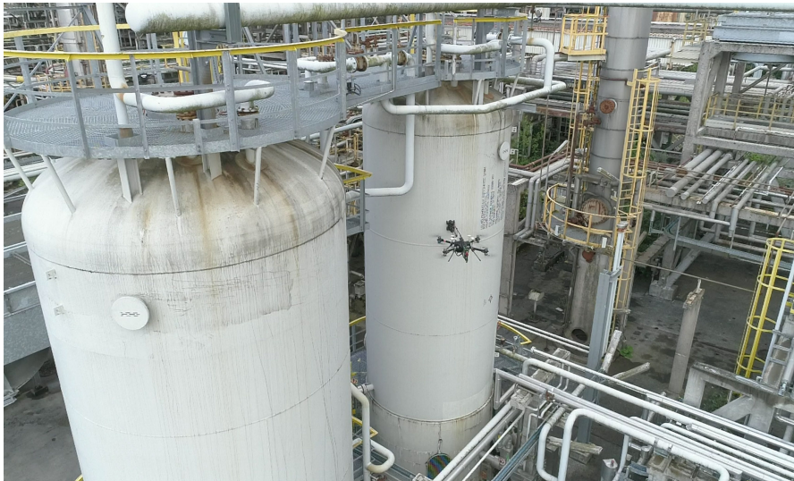
Figura 1.2 Aerox FADA-CATEC inspeccionando un tanque en una refinería.
