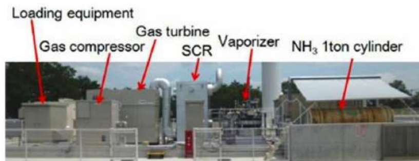
Figura 2.7: Microturbina de gas utilizando amoníaco
