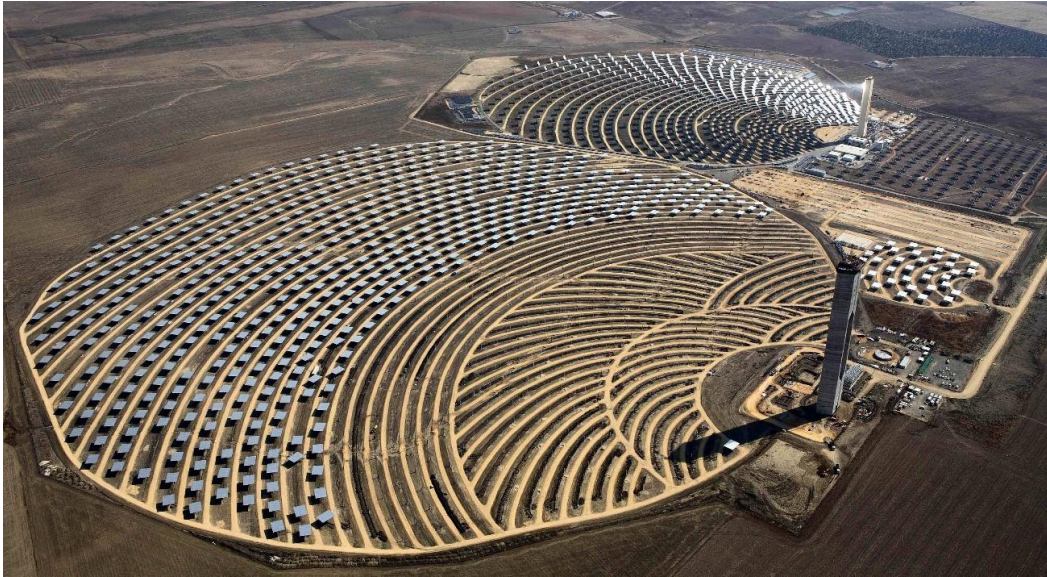
Ilustración 12. PS10 y PS20, plantas de receptor central de Abengoa en Sanlúcar la Mayor, Sevilla.
