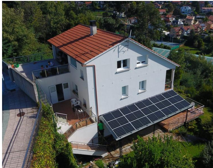
Ilustración 9. Instalación fotovoltaica en vivienda aislada en Pontevedra. (Energía, 2021)
