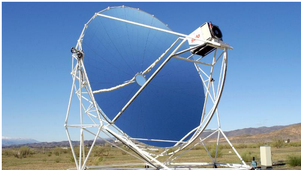
Ilustración 16. Prototipo de disco parabólico de PSA del proyecto hispano-alemán “EuroDISH”. (PSA, 2021)
