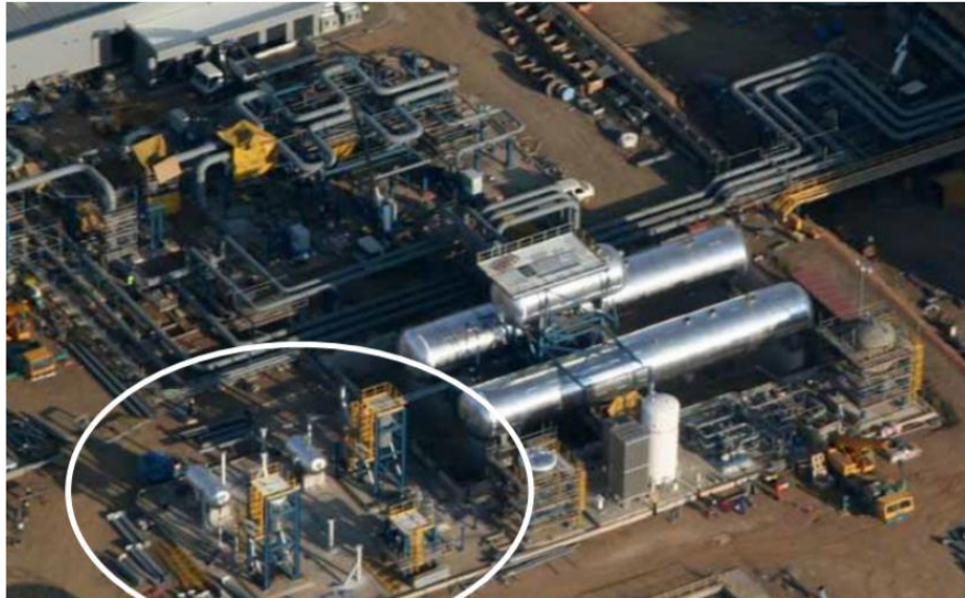
Ilustración 32. Sistema de Regeneración y de Ullage en planta CSP. (Prieto, 2021)
