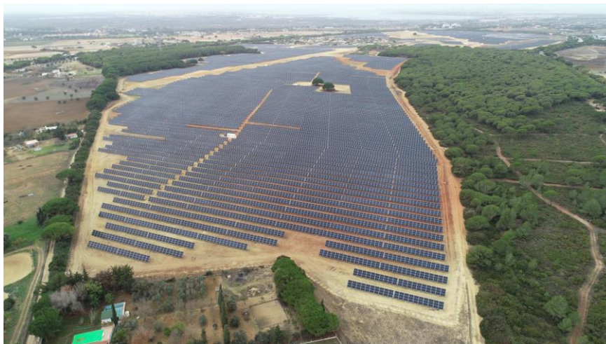
Ilustración 8. Planta solar fotovoltaica Miramundo de 50 MW, Puerto Real, Cádiz. (ISASTUR, 2021)
