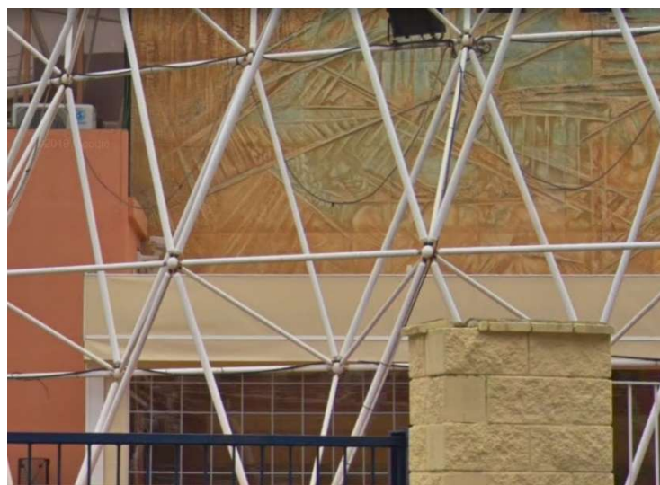
Figura 2.15. Estructura metálica articulada del Cartuja Sports (Sevilla) (12)
