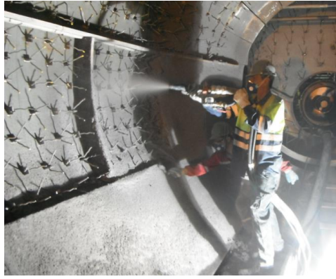
Figura 9. Ejemplo de instalación de refractarios gunitados. Refractarios ALFRAN.
