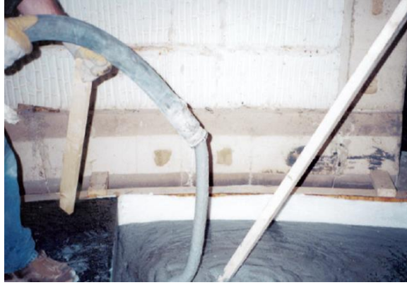
Figura 8. Ejemplo de instalación de refractario bombeable.
