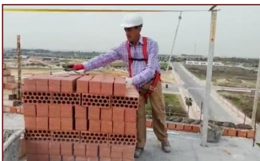
Imágenes 26, 27 y 28. Ejecución de citara del procedimiento PrAL06LPM008.
