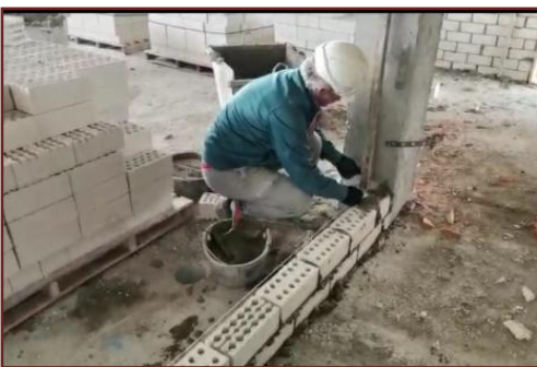
Imágenes 17, 18 y 19. Ejecución de citara del procedimiento PrAL06LEC007.
