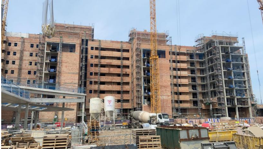
Imagen 5. Vista general de obra en fase de albañilería.
