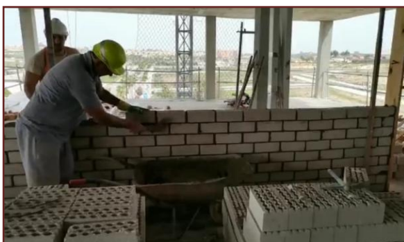
Imágenes 20 y 21. Ejecución de citara del procedimiento PrAL06LEC007.
