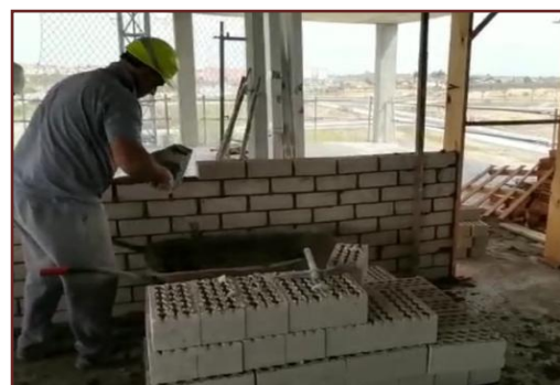
Imágenes 20 y 21. Ejecución de citara del procedimiento PrAL06LEC007.
