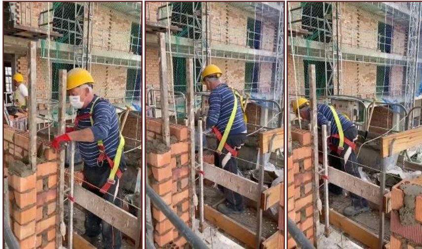
Imágenes 7,8 y 9. Ejecución de citara del procedimiento PrAL06LEC009.
