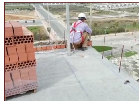
Imágenes 26, 27 y 28. Ejecución de citara del procedimiento PrAL06LPM008.
