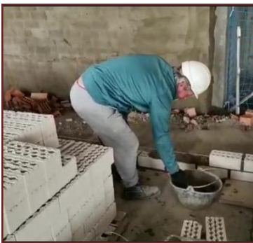
Imágenes 14, 15 y 16. Ejecución de citara del procedimiento PrAL06LEC007.
