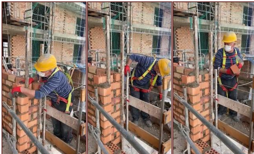
Imágenes 10, 11 y 12. Ejecución de citara del procedimiento PrAL06LEC009.
