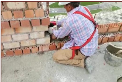
Imágenes 23, 24 y 25. Ejecución de citara del procedimiento PrAL06LPM008.
