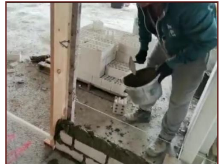
Imágenes 17, 18 y 19. Ejecución de citara del procedimiento PrAL06LEC007.
