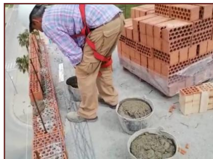
Imágenes 23, 24 y 25. Ejecución de citara del procedimiento PrAL06LPM008.
