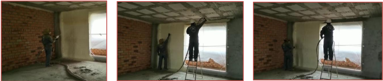
Imágenes 30, 31 y 32. Ejecución de proyección de aislamiento de poliuretano del procedimiento PrAM09TPP001
