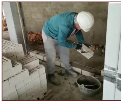
Imágenes 14, 15 y 16. Ejecución de citara del procedimiento PrAL06LEC007.
