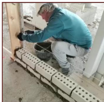
Imágenes 17, 18 y 19. Ejecución de citara del procedimiento PrAL06LEC007.
