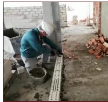
Imágenes 14, 15 y 16. Ejecución de citara del procedimiento PrAL06LEC007.
