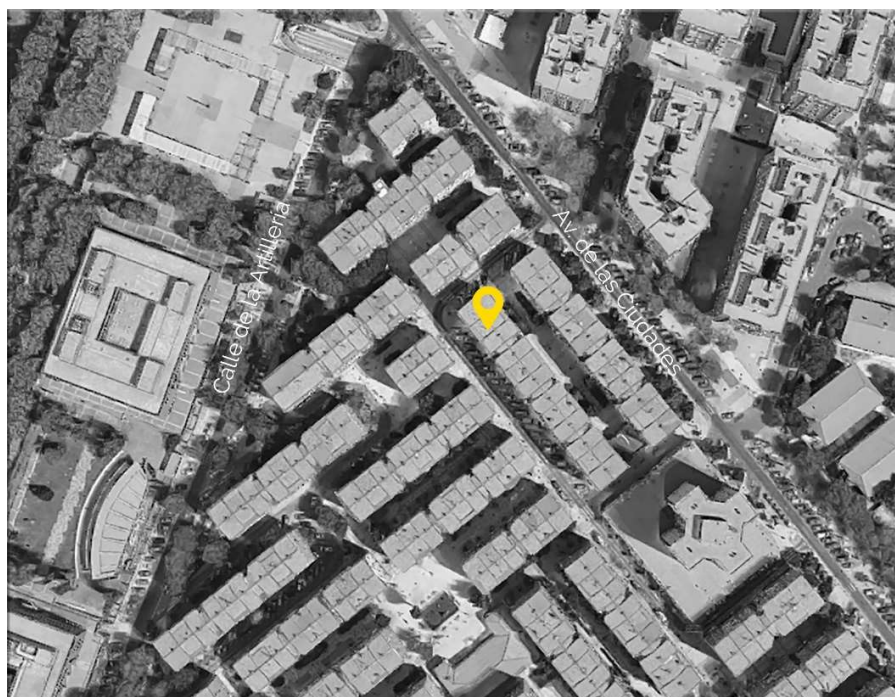
Ilustración 3 Edificio. Calle Crisantemo, Getafe.
