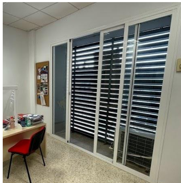
Fig. 26. Hueco de la fachada este (A.R.)
