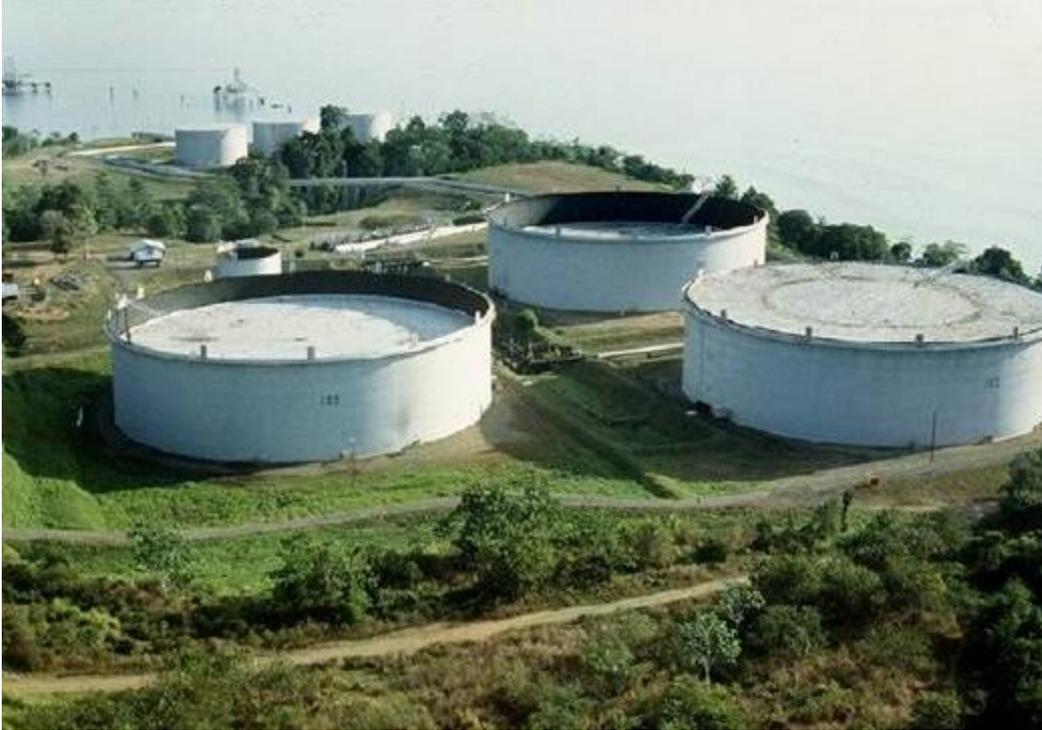
Ilustración 5. Tanque de techo flotante
