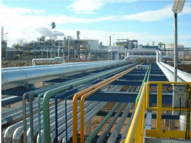
Ilustración 19. Racks de tuberías
