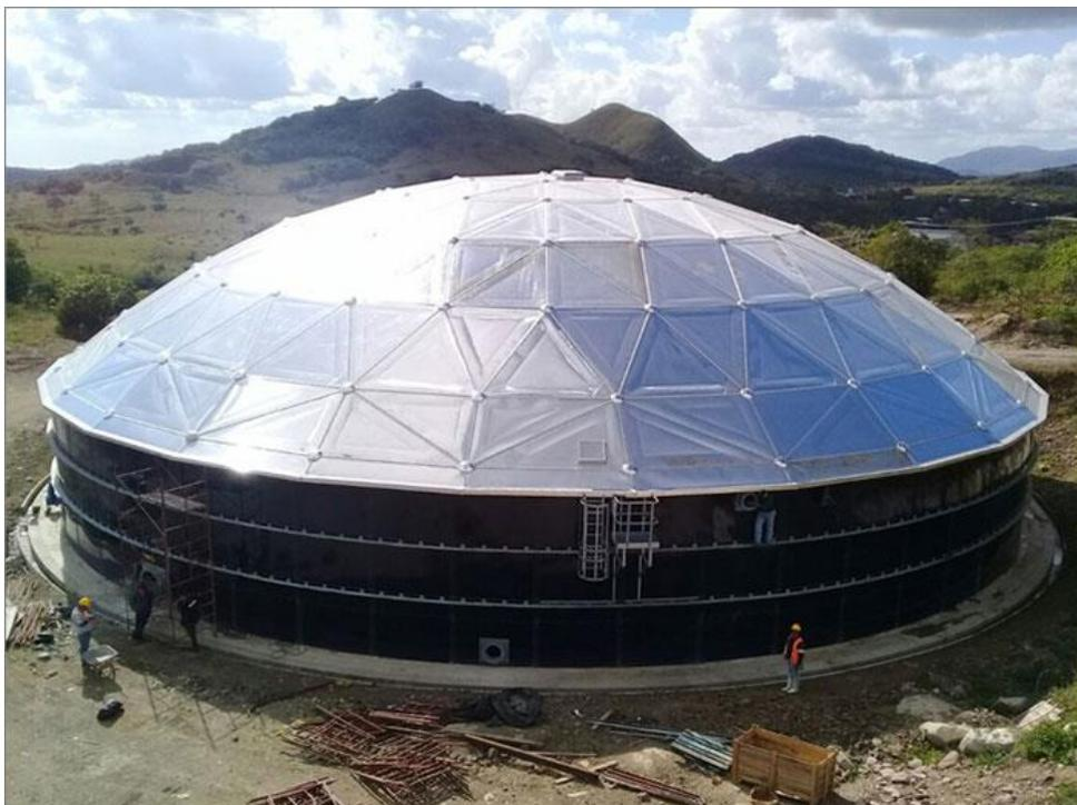
Ilustración 4. Tanque fijo de techo domo
