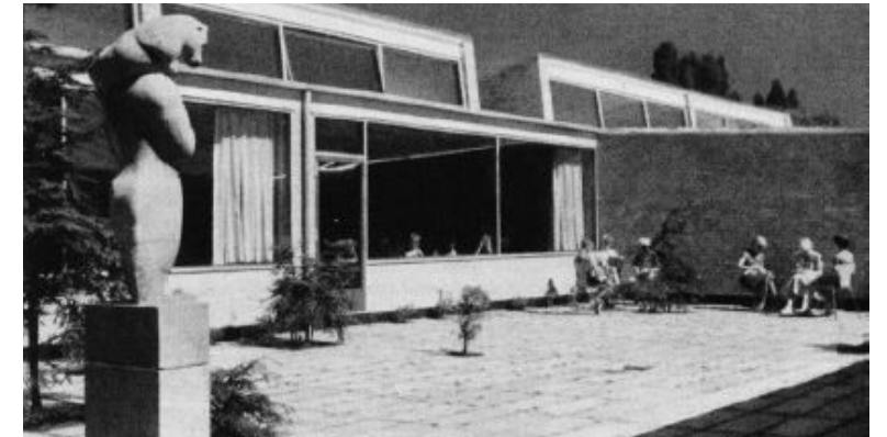
Imágenes 17 y 18_Escuela Munkegärds en Dinamarca. Arné Jacobsen (1951). La 1º foto consiste en una imagen aérea del colegio, la 2º es una imagen donde se puede apreciar el vínculo de un aula y el patio. donde se puede ver esos ventanales y lucernarios que proporcionan luz y ventilación.
