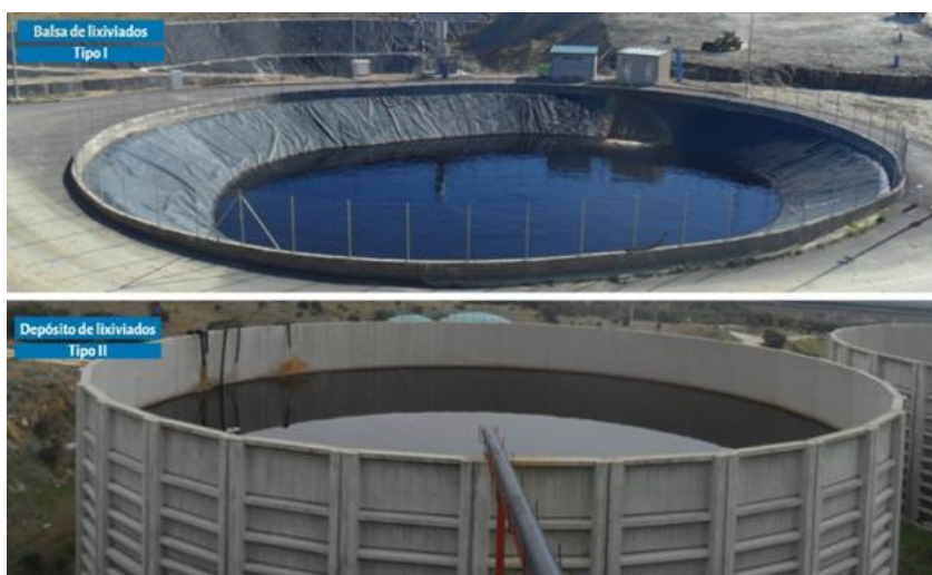
Figura 25. Tipo I: Balsa para el almacenamiento de lixiviados. Tipo II: Tanque de hormigón para almacenamiento de lixiviados.
