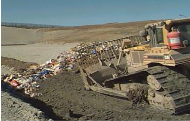
Figura 15. Bulldozer realizando la cobertura de un vertedero.
