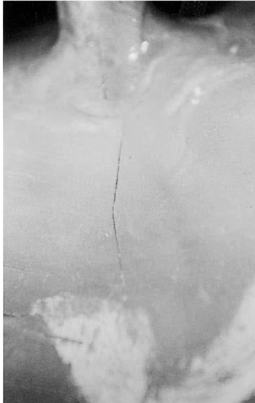
Figura 5-16. Una grieta en un álabe que se inicia en el orificio del alambre antivibración.
