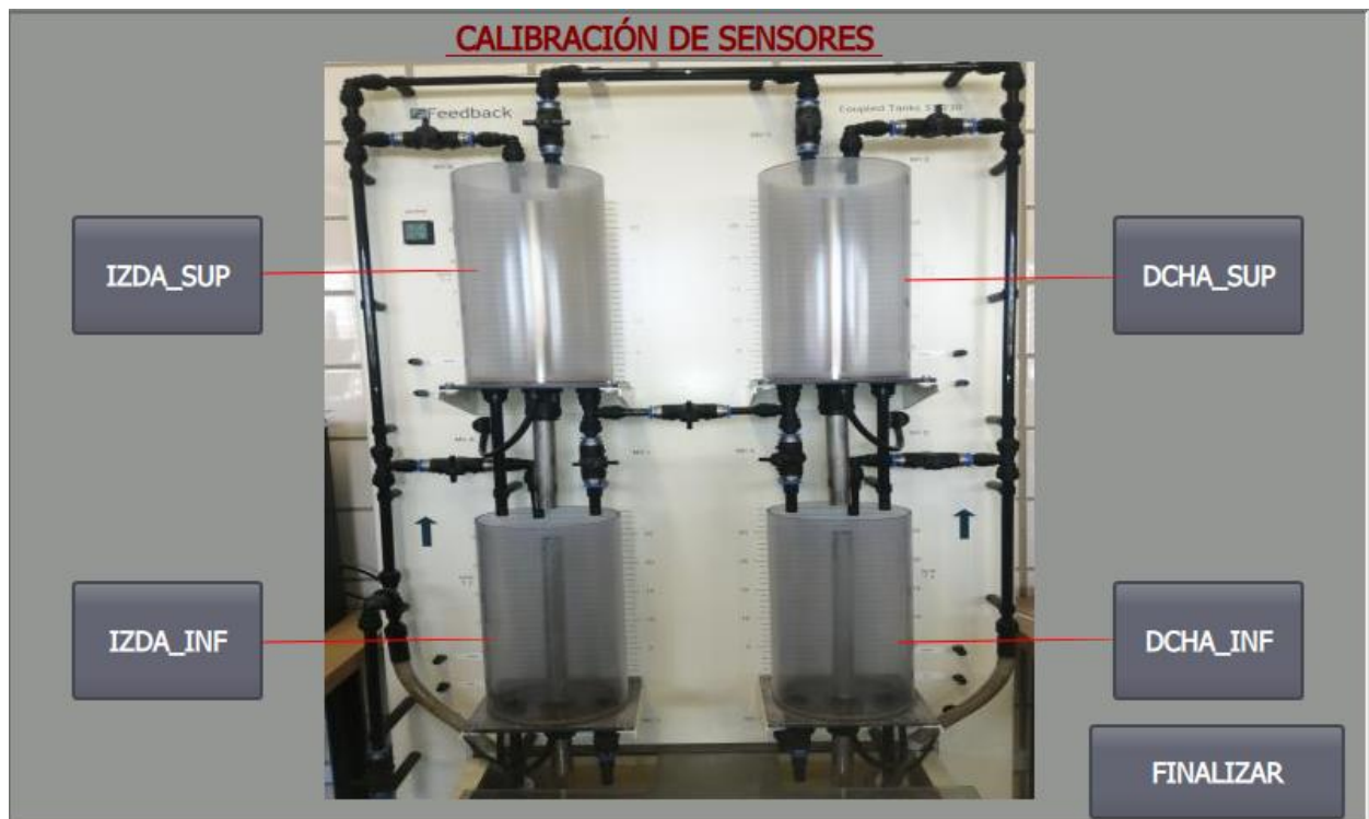
Figura 4-2. Calibración de sensores
