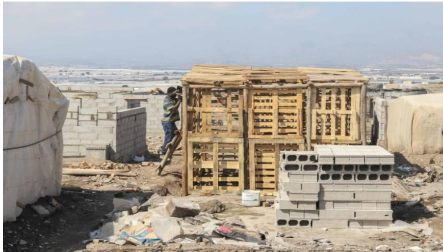
Imagen 5: Temporero reconstruyendo su vivienda. Fuente: diario público.
