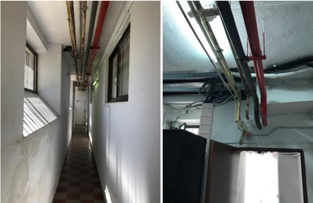
Imagen 54 Estado actual de los pasillos de servicio. Fuente: Elaboración propia.
