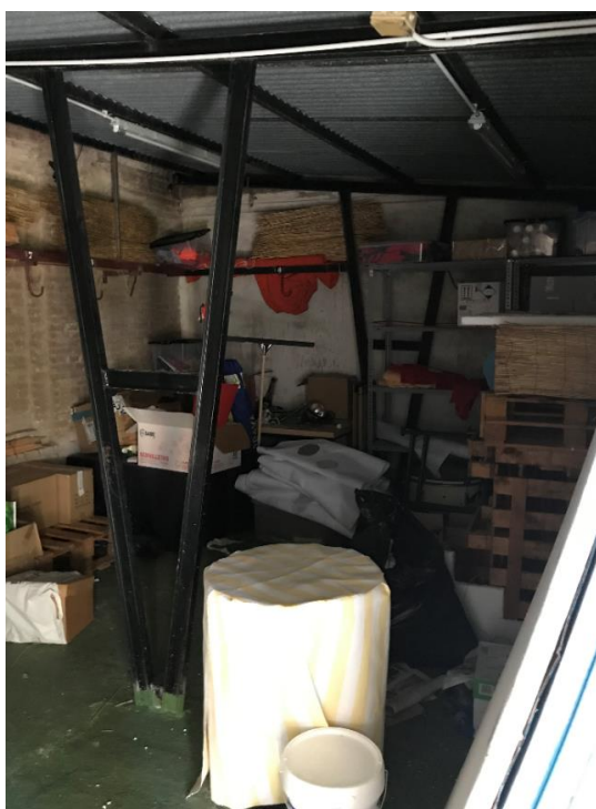
Imagen 55 Caos organizativo en almacén exterior. Fuente: Elaboración Propia
