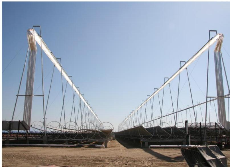
ILUSTRACIÓN 5. INSTALACIÓN FRESNEL DE 5 MWE (KIMBERLINA, CA) [5]
