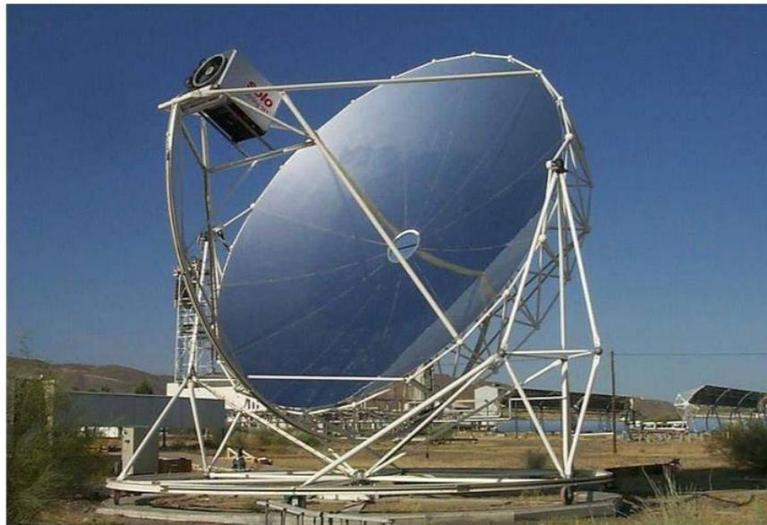
**ILUSTRACIÓN 1. DISCO SOLAR STIRLING EURODISH [1]**
