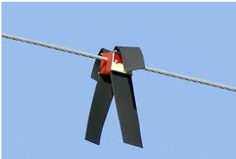
Figura 6-70. Medidas anticolidión. Aspas de polipropileno colocadas en X
