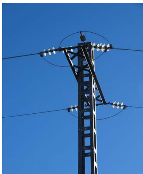
Figura 4-10. Montaje con aislador rígido
