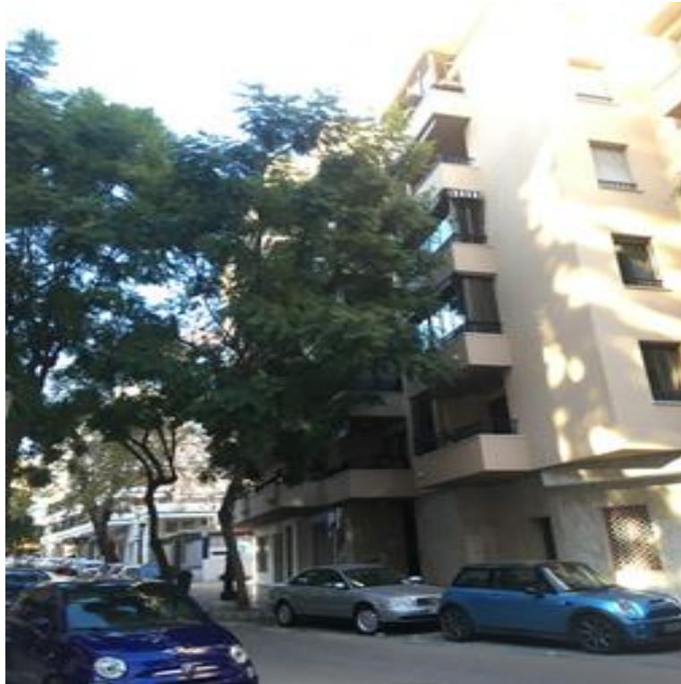
Fig. 24. Ejemplo de los problemas de gestión de árboles urbanos, que llega a introducirse en casas residenciales en Marbella. Fuente: Elaboración propia
