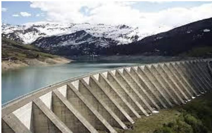
Figura 4 – Presa de contrafuertes
