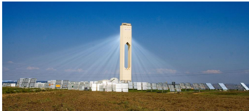
Figura 5. Planta termosolar de Heliostatos, PS10.
