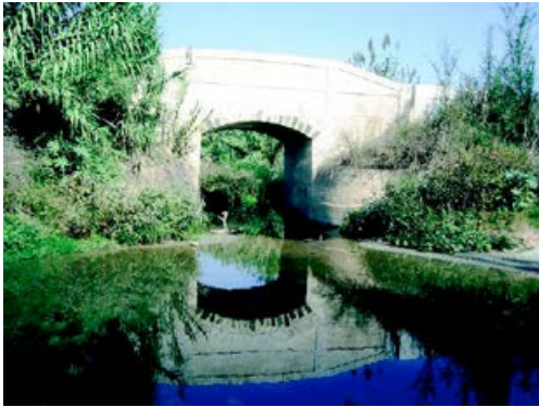
Fig. 2 Conocido como el Puente Romano del Riopudío
