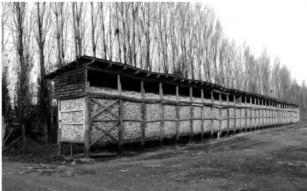
Fig. 2 Bodega de secado de maíz en Linares, Chile.2008. Fot. Manuel Gaete. En La contemporización de lo vernáculo en la arquitectura: el caso del Valle Central de Chile , de José Luis Uribe Ortiz
