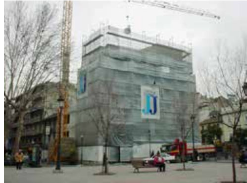
06 Envoltura de las obras del edificio Zaida. Fotografía de Juan Domingo Santos.
