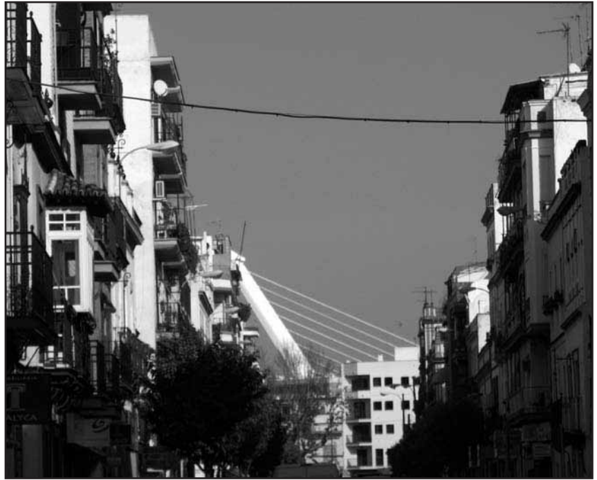
La convivencia del casco antiguo con un gigante: el pilar del Alamillo o la metáfora de la grúa
