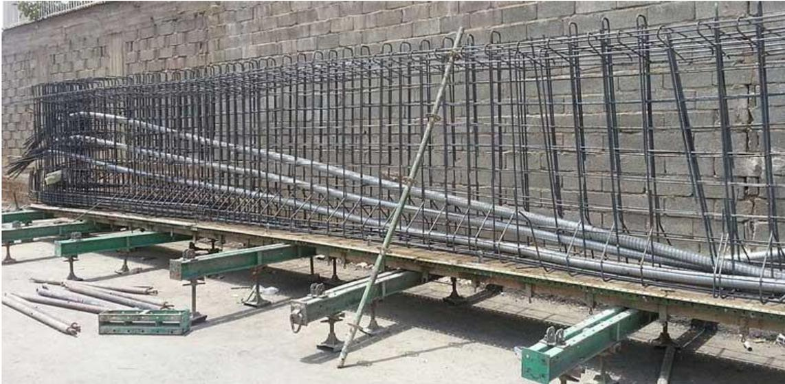
Figura 2-3. Proceso de pretensado con armadura postesa [9].
