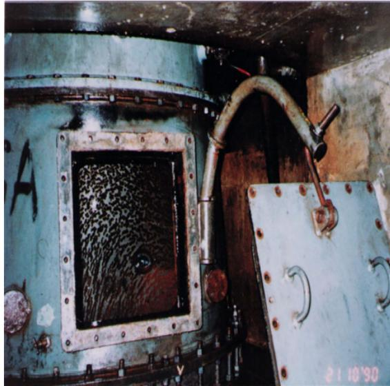
**Figura 1.9** Puerta del tubo de aspiración, Central Hidroeléctrica Ok Menga, Papúa Nueva Guinea..
