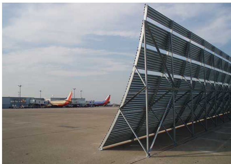
Figura 4.1 Deflector estándar en aeropuertos contra chorro o jet blasts [20].
