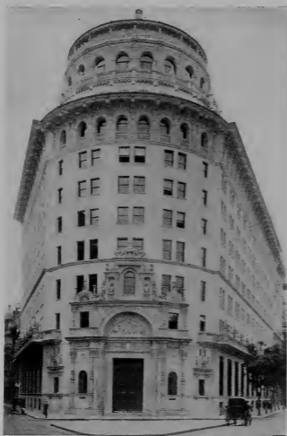
EDIFICIO BANCARIO EN BUENOS AIRES
