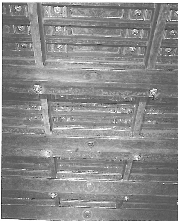
Armadura de la actual Biblioteca de Buenas Letras. ( H . 1502-1506)
