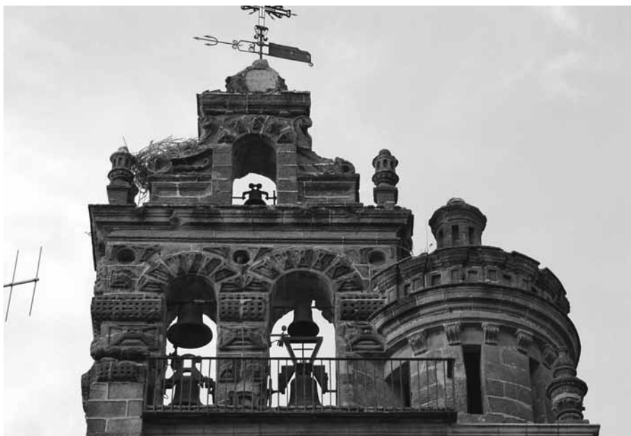
Figura 11. Espadaña y caja circular de la escalera de caracol.
