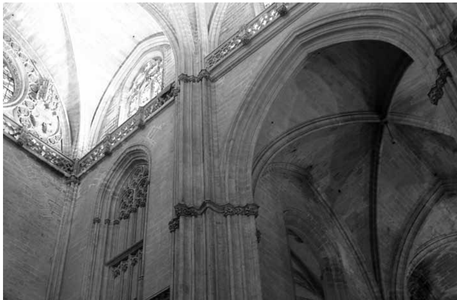
Figura 9. Catedral de Sevilla. Vista interior del brazo meridional del crucero y su encuentro con la nave colateral externa, junto a la Capilla de la Antigua.
