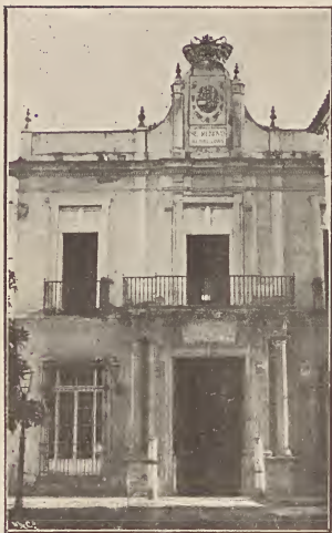
Puerta del Apeadero.
