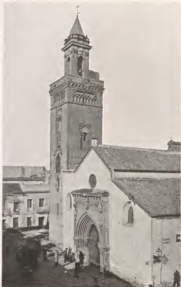
TORRE Y FACHADA DE SAN MARCOS
