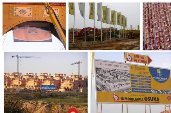
Figura 8: Proceso urbanizador del Aljarafe, en el Área Metropolitana de Sevilla. Fotografías de Luis A. Zambrana.
