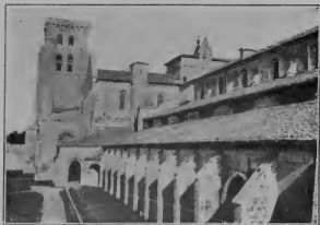
BURGOS. — Monasterio de las Huelgas. Vista exterior.
