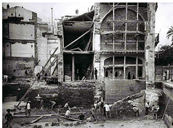
Fig. 5. Construcción de la sede de Telefónica (1926-28). Al fondo se aprecia la única preexistencia conventual de la Casa Grande de San Francisco: la Capilla de San Onofre. Fuente: http://www.elpasadodesevilla.com/2013/11/la-huella-de-un-convento.html
