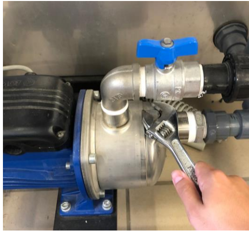
Figura 4.7 Extracción de aire de la bomba
