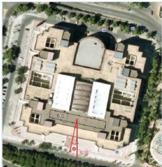
Figura 1.4 Localización de la planta termosolar en la azotea del Edificio Plaza de América [4].
