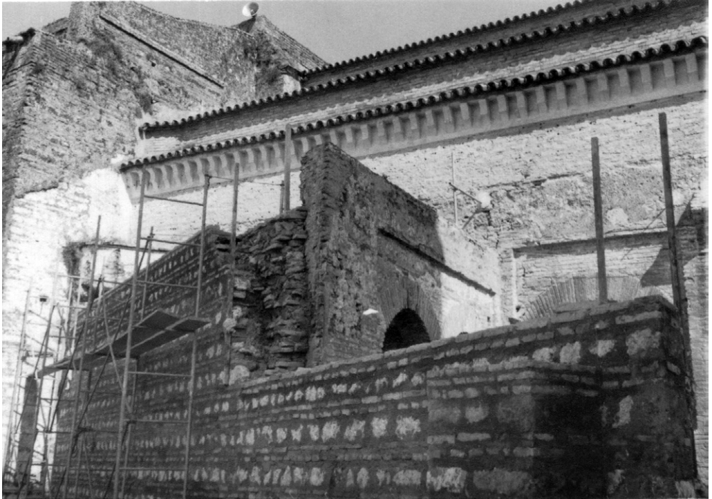
Fig. 6. Proceso de reconstrucción del muro de cierre del patio de Santa María María de la Granada por su lado norte. Autor: D. Rafael Manzano.
