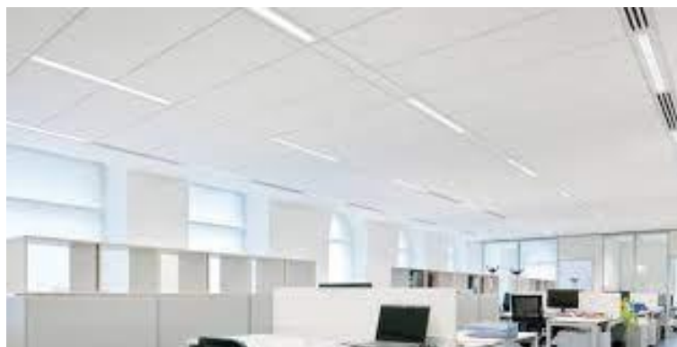
Figura 6.23 Falso techo en zonas administrativas [47].
