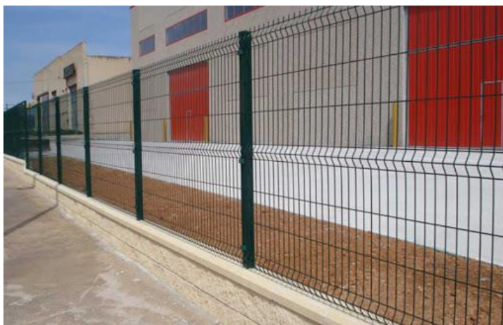
Figura 6.13 Vallado rígido con muro de obra [37].
