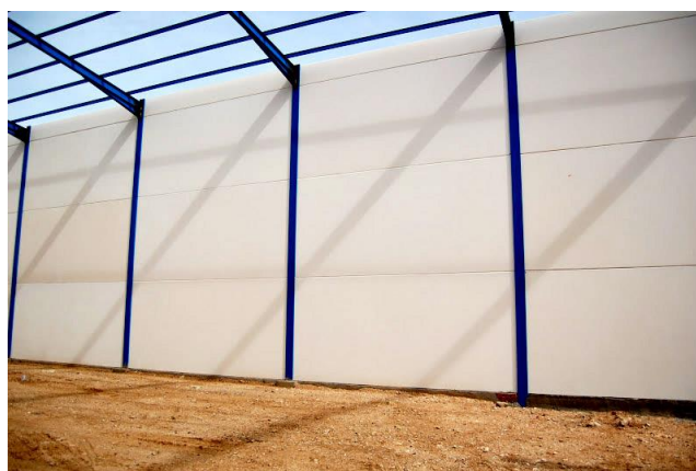
Figura 6.20 Cerramiento lateral. Placas de hormigón prefabricado [42].
