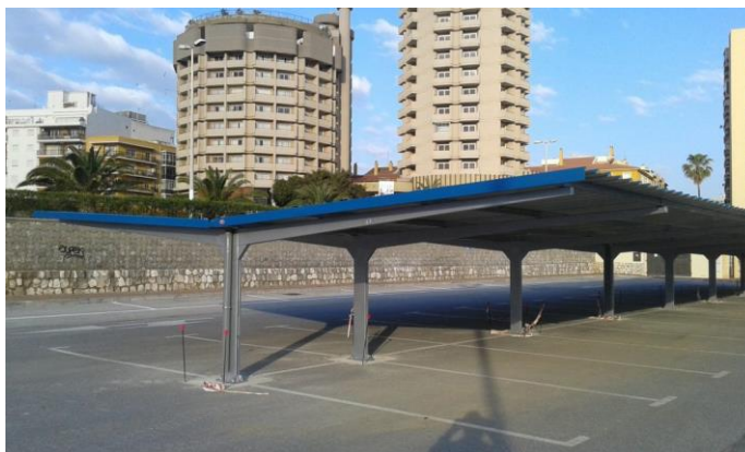
Figura 6.12 Aparcamientos con marquesina [36].
