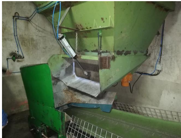
Figura 5.4 Boca de la tolva de recepción.
