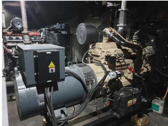
Figura 12. Grupo electrógeno 60 kVA.
