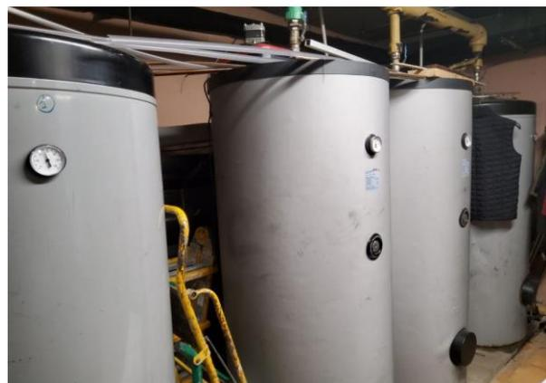
Figura 14. Depósitos interacumuladores existentes.
