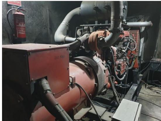
Figura 10. Grupo electrógeno 250 kVA.
