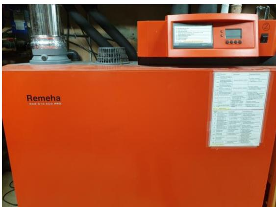
Figura 13. Caldera Remeha 170 kW existente.
