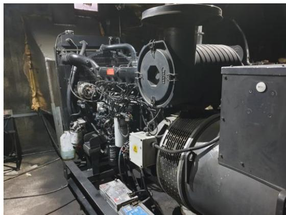
Figura 11. Grupo electrógeno 220 kVA.
