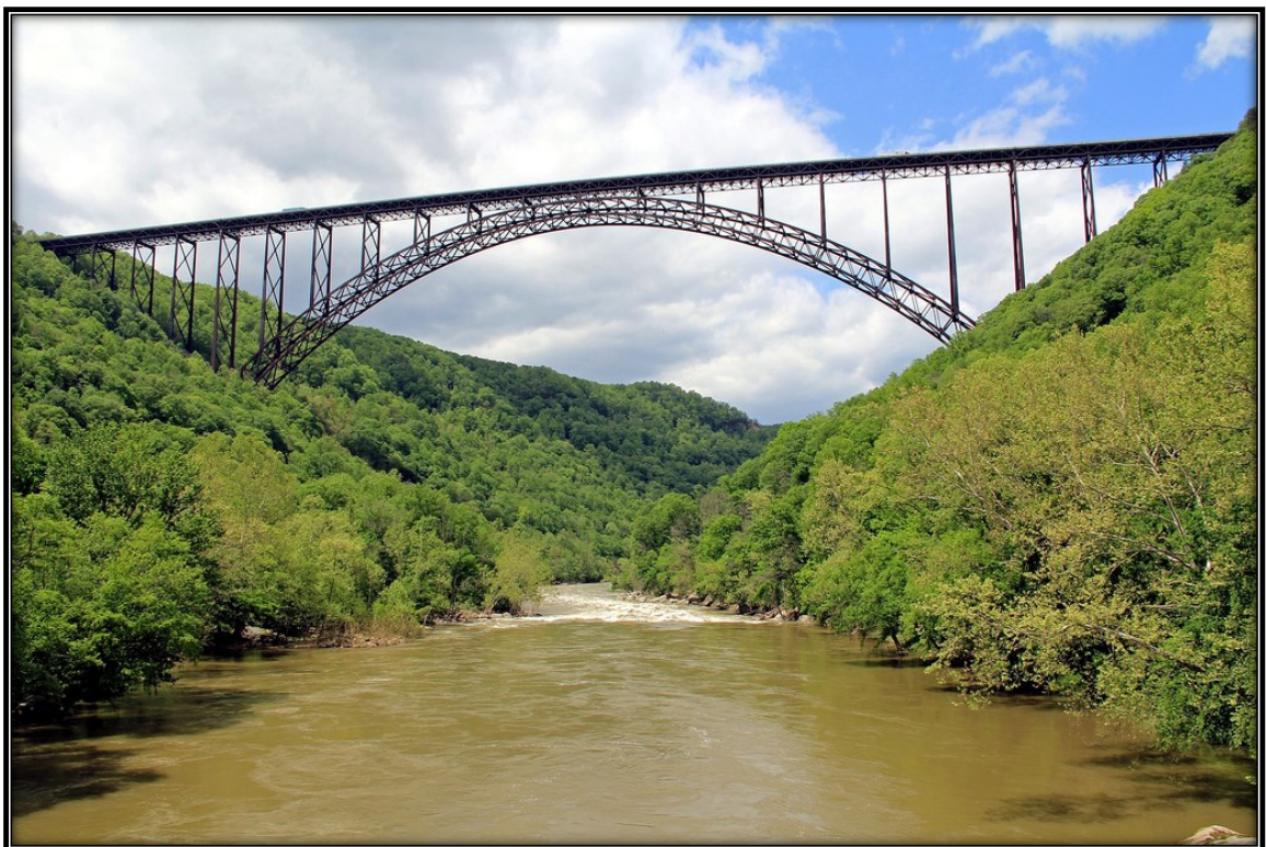
Figura 1.3 - Puente New George. Fuente: Megaconstrucciones.net 6
