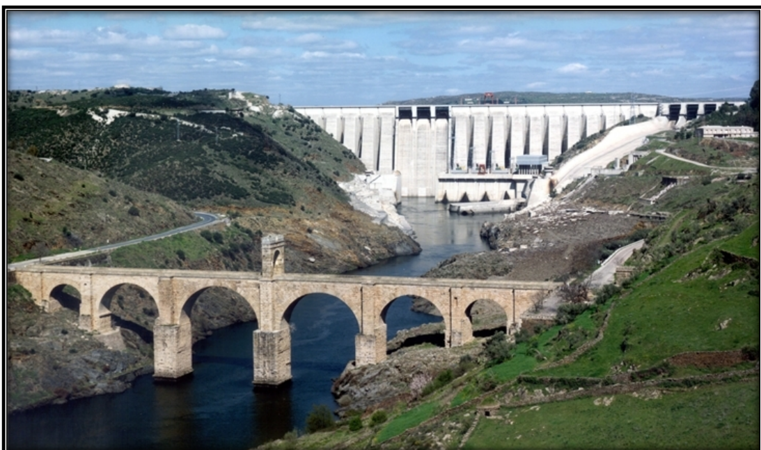
Figura 1.1 - Puente Romano de Alcántara. Iberdrola 2
