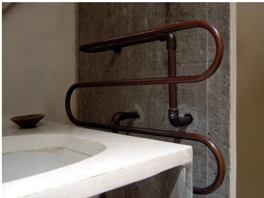
Figura 3: De esta manera resaltaba Mendes da Rocha “lo feo” en el baño de la Residencia Butantã . Vista detallada del toallero formado por las tuberías junto a la bañera. Fotografía de Santiago Carvajal.
