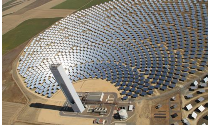
Fig. 1.1.1: Imagen de la planta solar de torre PS20 de Abengoa.
