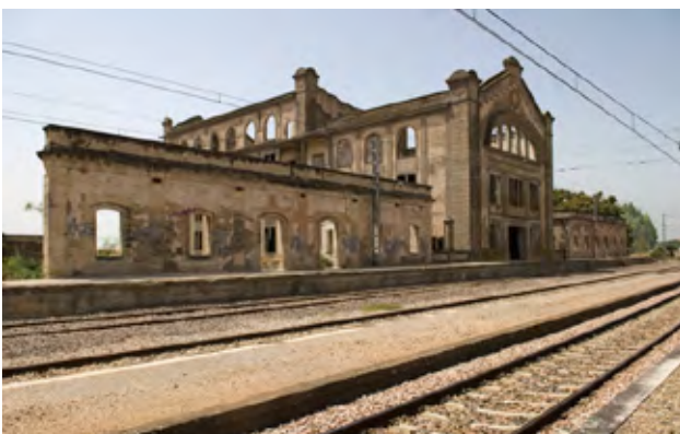
Fábricas de harinas y tejidos de yute Sánchez Pastor en Peñaflor (1926). Vista parcial exterior del edificio principal y vías del ferrocarril Fotos: Fondo Gráfico IAPH (Juan Carlos Cazalla)
