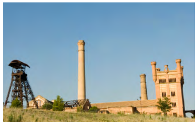
Conjunto de la Mina en Villanueva del Río y Minas, Sevilla (1920-30). Vista general del pozo n.º 5. Empresa MZA
