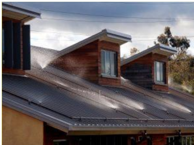
Figura 5. Sistema de enfriamiento evaporativo – radiante.
