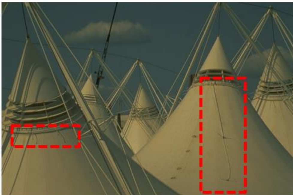
Figura 7. Tipo cobertura de baja absorción Expo 92
