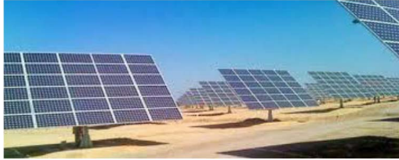
Figura 3.19. Central Solar Fotovoltaica con seguimiento a un eje [8].
