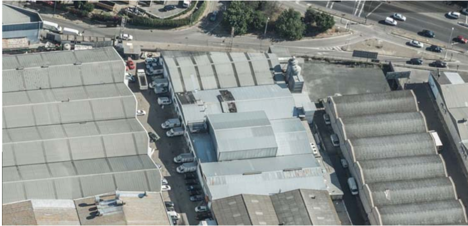
Figura 2.1. Cubiertas de la nave bajo estudio
