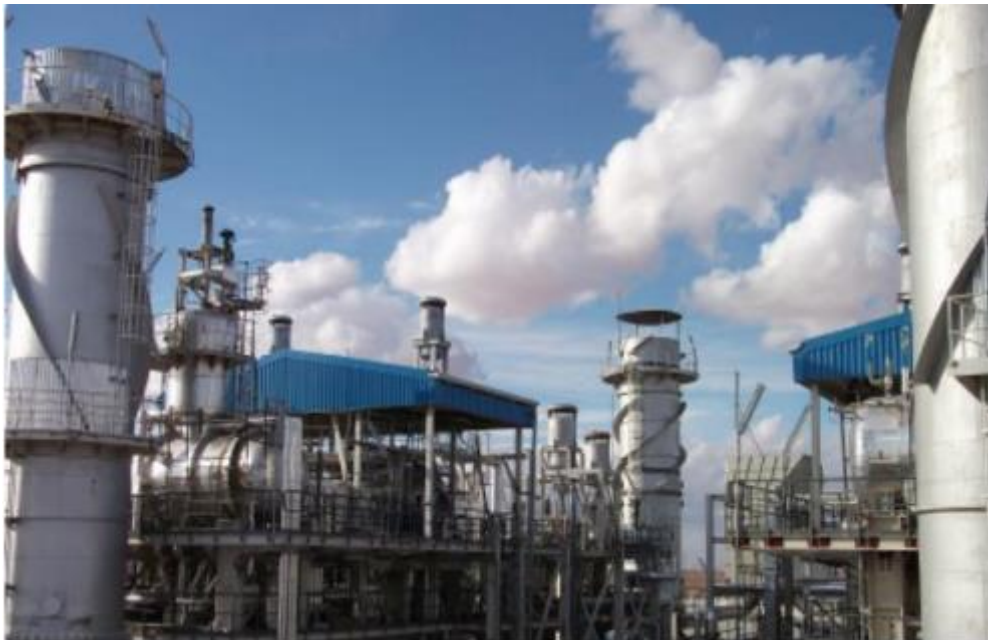
Figura 2.3. Central híbrida solar-gas Hassi R'Mel. (Rivet, 1935)
