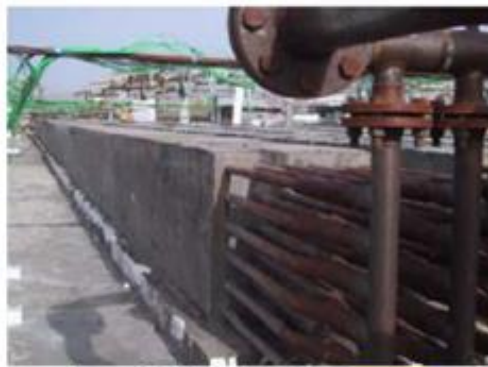
Figura 4.15 Módulos de hormigón, planta Almagro. (Sales et al., 2016)
