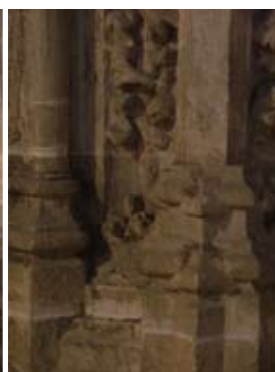
Detalle nuevo basamento pilares de J. Esteve y López. Foto: José Luis Gómez Villa, IAPH
