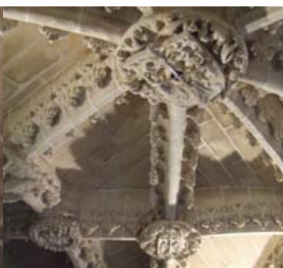
17/01/2007. Prótesis: sujeción clave central crucero. Foto: Taller de Inmuebles, IAPH
