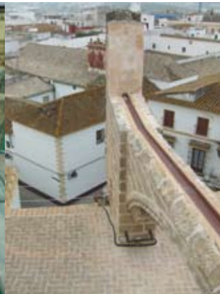
02/10/2007. Encamisado chapa de cobre canal arbotante. Foto: Taller de Inmuebles, IAPH
