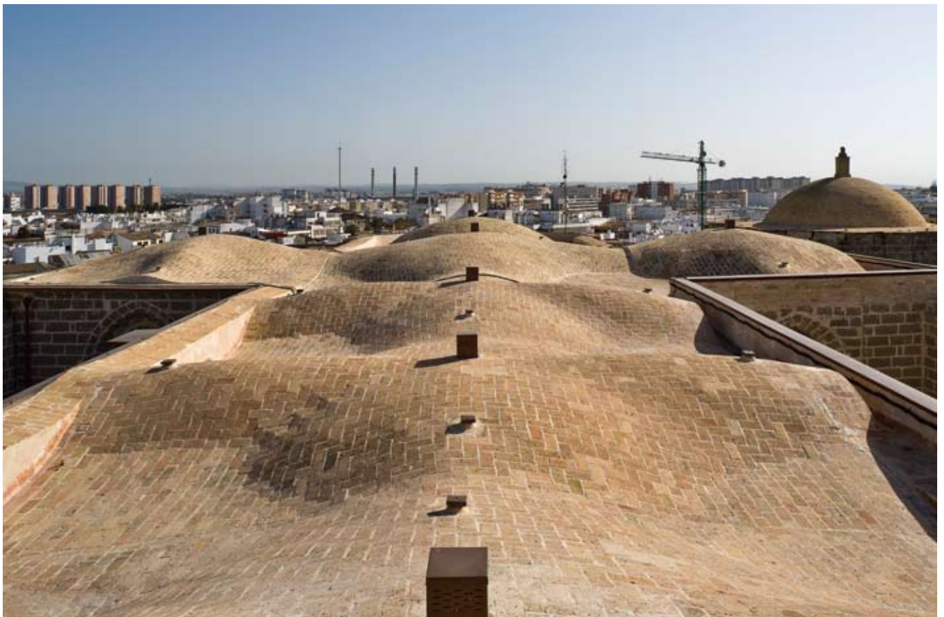
Cubiertas de San Miguel tras la intervención. Foto: Fernando Alda
