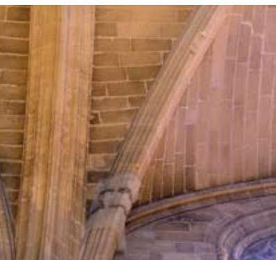
19/05/2004. Medidas de urgencia previas a la ejecución de las obras. Foto: Taller de Inmuebles, IAPH
