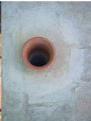
16/05/2007. Respiraderos: nuevas piezas cerámicas. Foto: Taller de Inmuebles, IAPH
