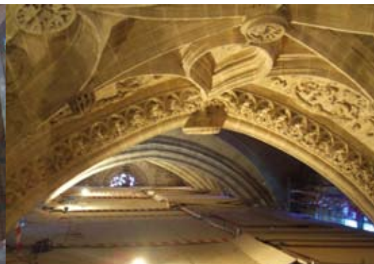
07/03/2007. Plataformas de trabajo Nave Central. Foto: Taller de Inmuebles, IAPH
