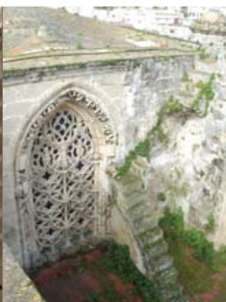
10/03/2004. Cubierta Capilla del Cristo de la Salud. Estado inicial. Foto: Eugenio Fernández Ruiz, IAPH
