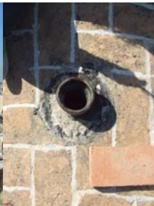
11/05/2007. Respiraderos: pasivación y protección de piezas de hierro. Foto: Taller de Inmuebles, IAPH
