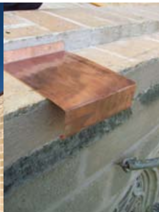
19/04/2007 Prueba goterón de chapa de cobre. Foto: Taller de Inmuebles, IAPH
