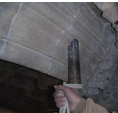
04/03/2004. Estudios previos: Extracción de testigos. Foto: Taller de Inmuebles, IAPH
