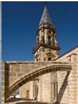
Intervención en pretilos y paramentos. Estado final. Foto: Fernando Alda
