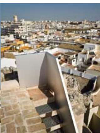
15/02/2008. Estado Final escalera acceso cubierta Capilla Cristo de la Salud. Foto: Fernando Alda
