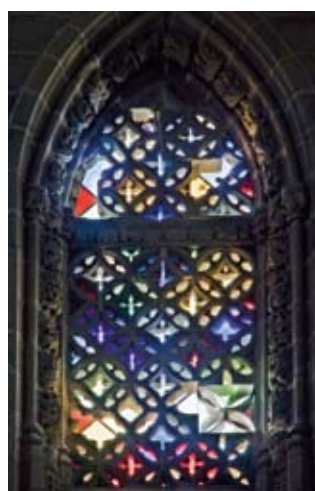
Reintegración puntual de la geometría soporte con prótesis de acero inoxidable y elementos de protección exterior de vidrieras. Foto: Fernando Alda
