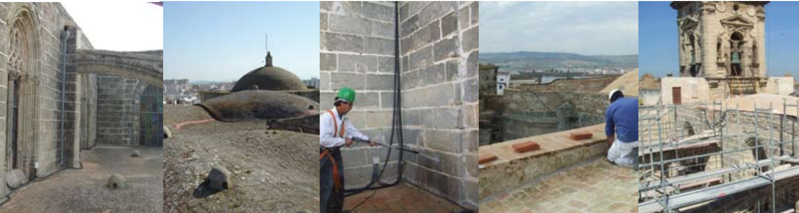
11/02/2004. Sistema de evacuación de pluviales. Estado Inicial. Foto: Taller de Inmuebles, IAPH
