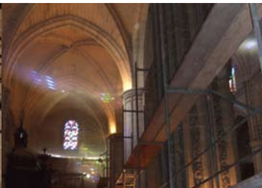
15/11/2006. Medios auxiliares: montaje de andamios y plataformas de trabajo. Foto: Taller de Inmuebles, IAPH
