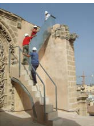
05/09/2007. Visita de obra ejecución escalera. Foto: Taller de Inmuebles, IAPH
