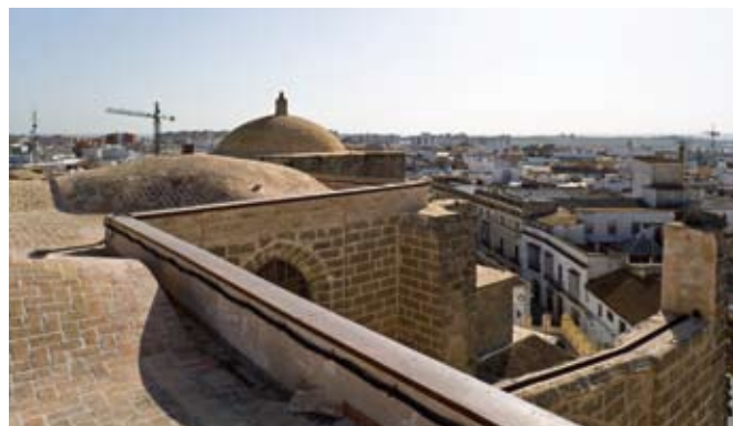
Actuación en pretilos. Recuperación de canales de arbotantes. Foto: Fernando Alda
