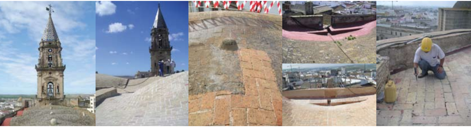
27/02/2004 Estado Inicial. Cubierta Nave Central. Foto: Eugenio Fernández Ruiz, IAPH
