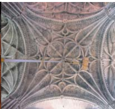
10/03/2004. Inspección visual de las bóvedas mediante grúa extensible. Foto: Eugenio Fernández Ruiz, IAPH
