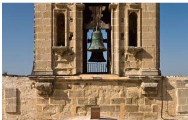
Actuación en la base de la torre. Tratamiento fábrica, reintegración volumétrica cornisa, protección de hueco. Foto: Fernando Alda
