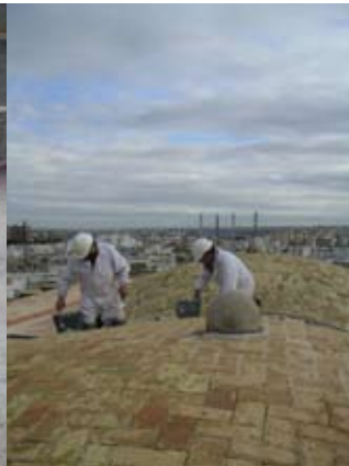
22/11/2006. Rejuntado con mortero de cal. Foto: Taller de Inmuebles, IAPH
