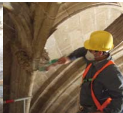
01/01/2006. Cepillado manual. Foto: Taller de Inmuebles, IAPH
