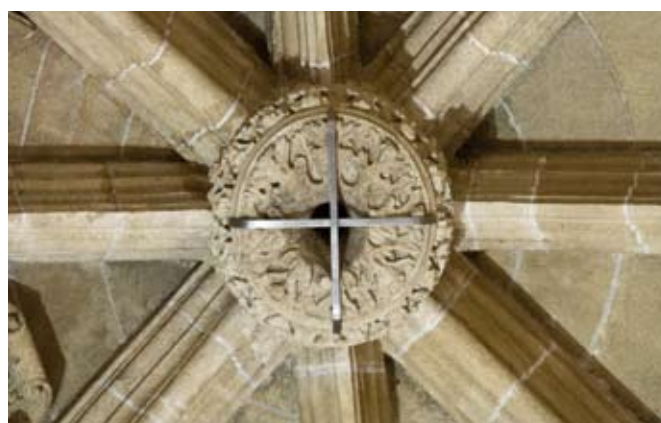
Anclaje clave central en acero inoxidable. Foto: Fernando Alda
