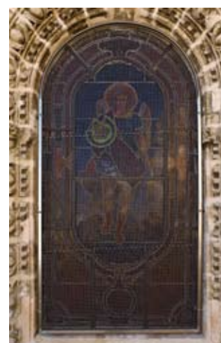
Reintegración puntual de la geometría soporte con prótesis de acero inoxidable y elementos de protección exterior de vidrieras. Foto: Fernando Alda
