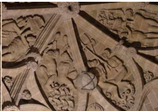
19/05/2004. Medidas de urgencia previas a la ejecución de las obras. Foto: Taller de Inmuebles, IAPH
