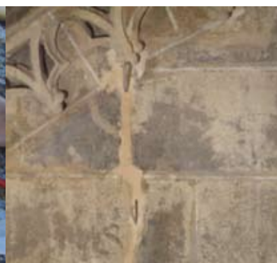
01/01/2006. Sellado de grietas. Foto: Taller de Inmuebles, IAPH
